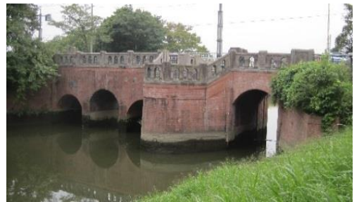
大場川から見た閘門橋
