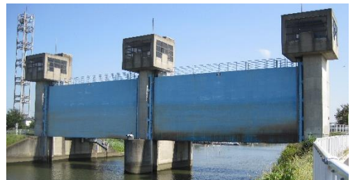
中川から見た新大場川水門
