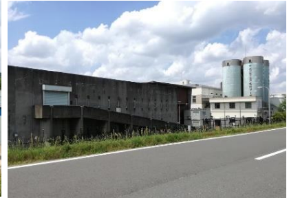
金町浄水場 (2019年5月4日)
