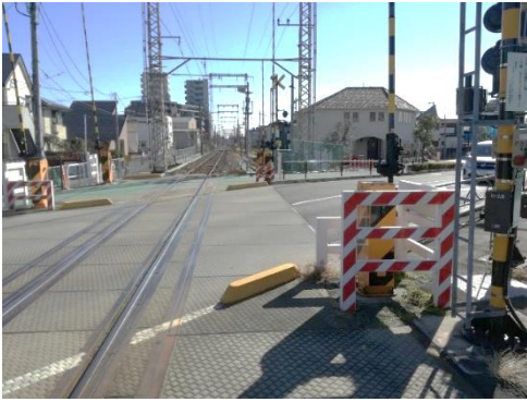
新金線、三重田街道踏切から南方へ 2019年1月21日撮影
