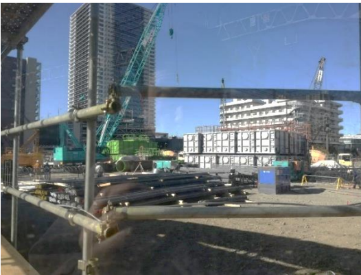
三菱製紙中川工場跡地、マンション建設現場から理科大キャンパス方面を望む（2019年1月21日撮影）
